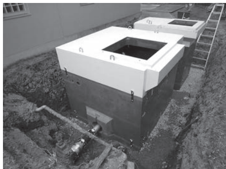
第10図 開口部の隙間と外側の処理が終わった地下ピットの様子
