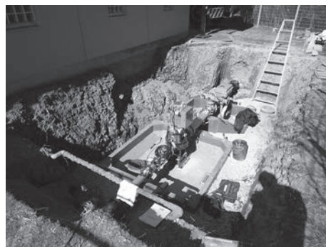
第9図 地下ピット底面部据付、配管工事完了後の様子
