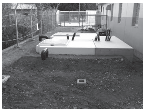
第11図 埋戻し後の地下ピットの外観
