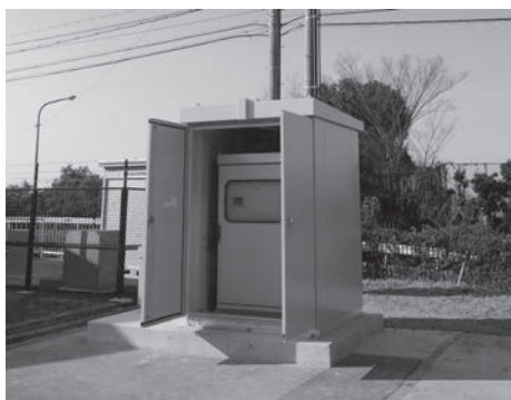
第12図 金属製キャビネットにシステム制御盤を取めた様子
